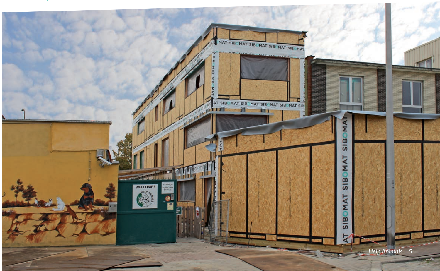
Het skelet van het gebouw is geplaatst. Indrukwekkend, neen?
